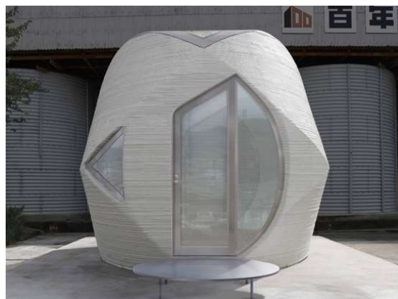
セレンディックスの3D プリンター住宅「serendix10」 設計: CLOUDS Architecture Office
